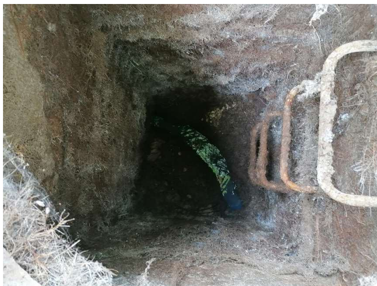
Figure 5 : Défaut d'étanchéité constaté : présence de racines dans un regard
