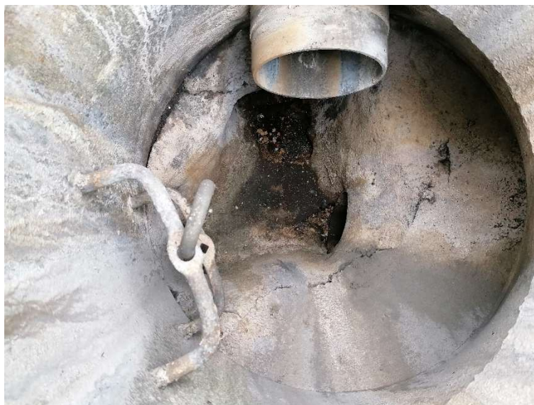
Figure 9 : Exemple de défaut de structure constaté : radier usé et béton fissuré dans un regard
